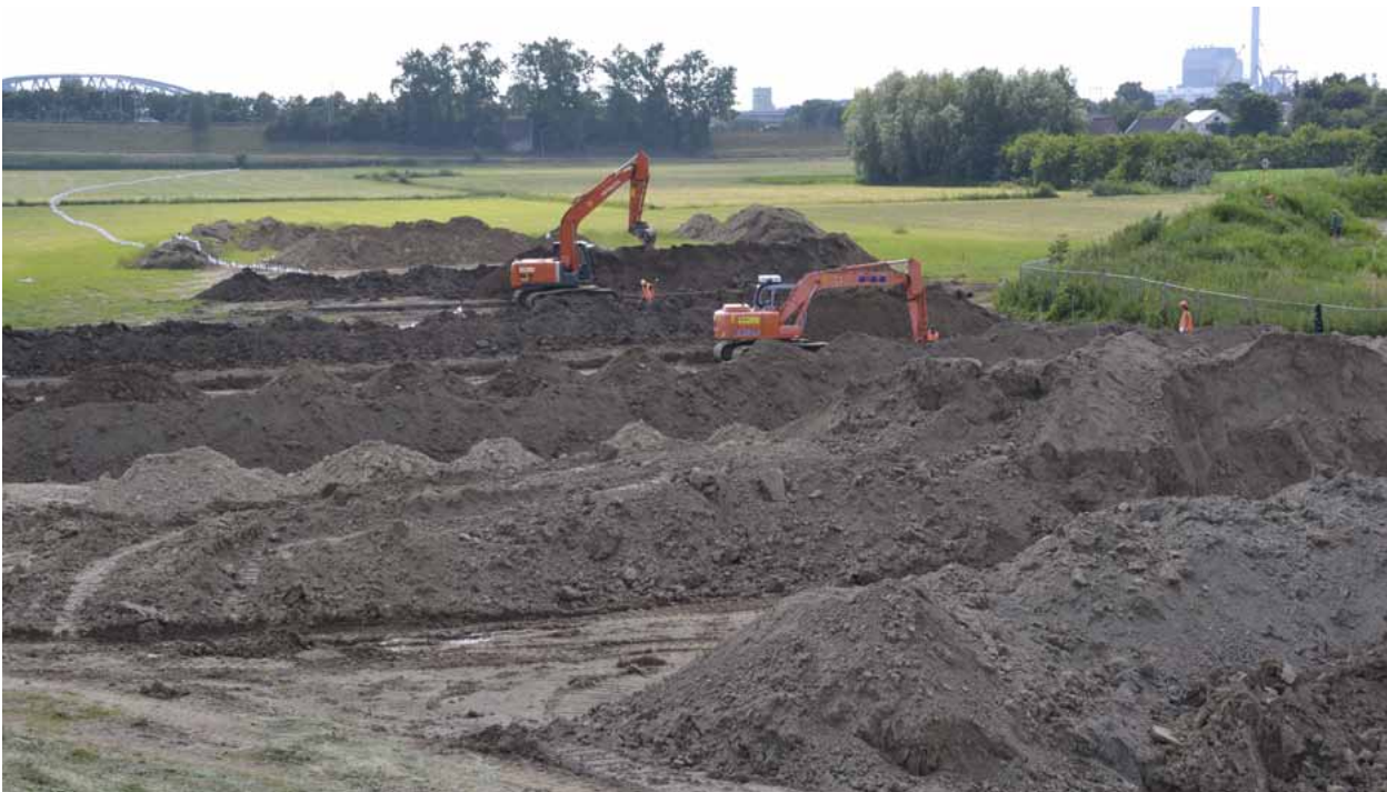
Figuur 13.2. Opgravingsputten in zone P9/57 op 27 juni 2012. De witte vlaggetjes geven de loop van de te graven nevengeul aan. BLAN
