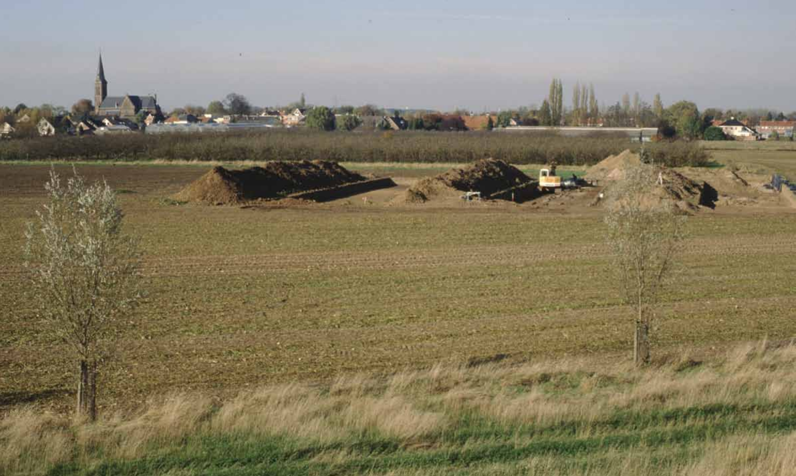
Figuur 13.3. Overzicht van het graafwerk van project Bdl, vanaf de Bemmelsedijk naar het noordwesten gezien.
